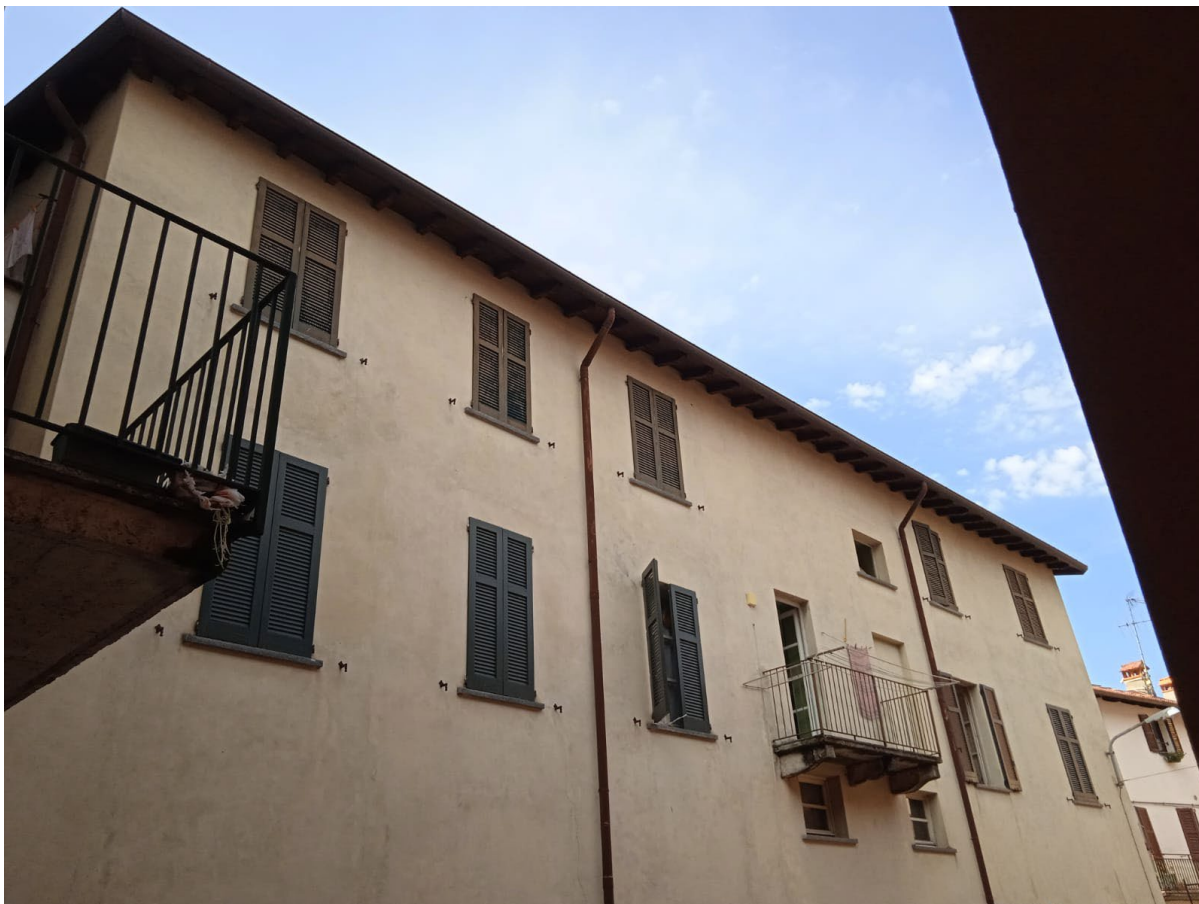
Figura 3 – Facciata lato sud
