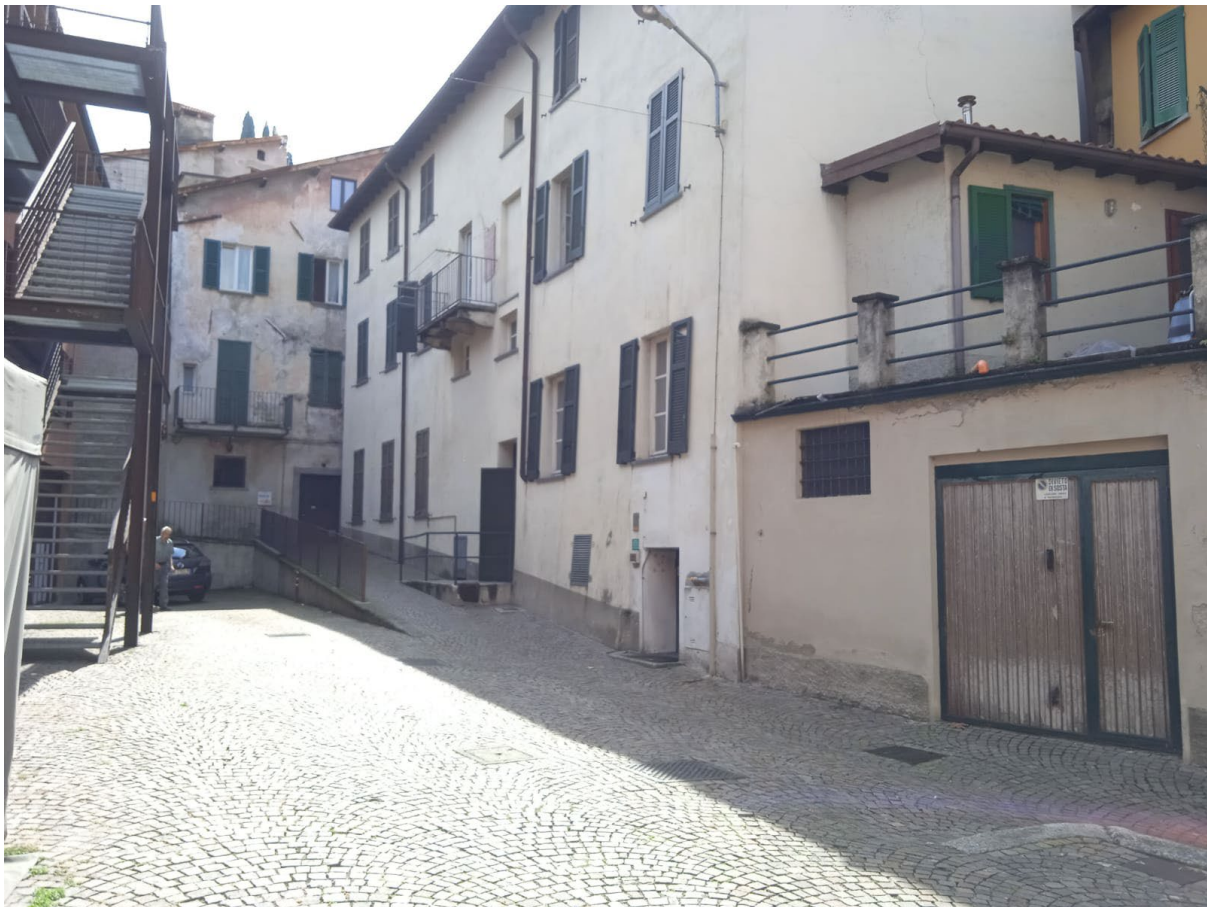
Figura 2 – Facciata principale lato nord
